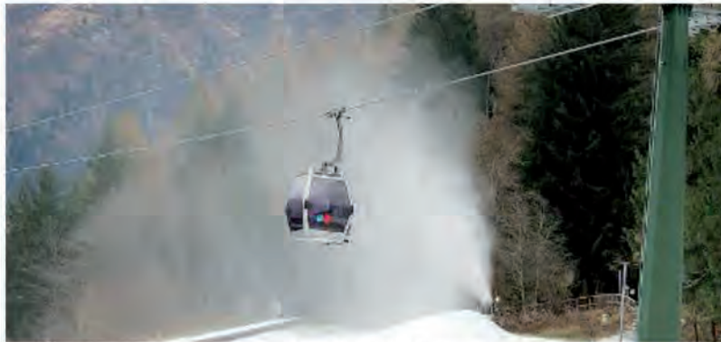
Impianti in funzione. La cabinovia Ponte-Tonale è comunque aperta
